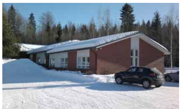
Klaukkalan keskustassa sijaitseva toimisto on keskeisellä paikalla hyvien kulkuyhteyksien varrella.
